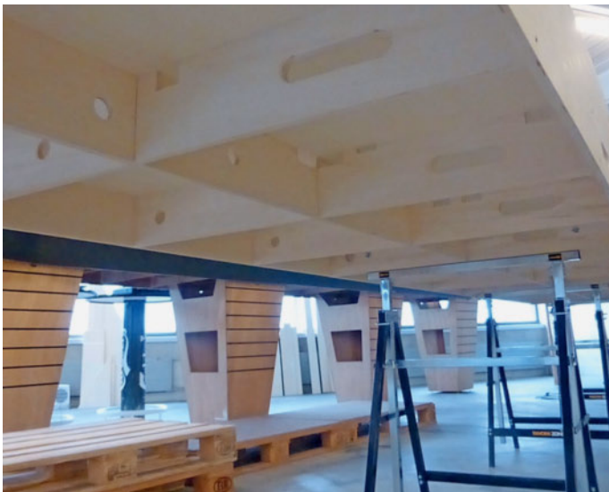
Der Blick auf die Unterseite der Segmente des neuen Abstellbahnhofs.
